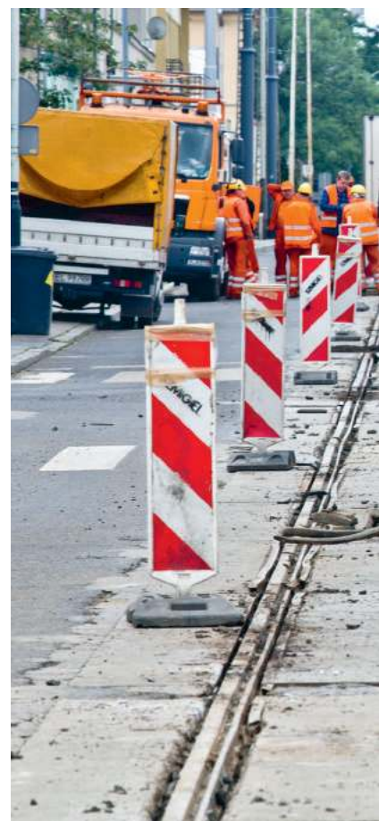
Remont torowiska przy ul. Grochowskiej w Warszawie
