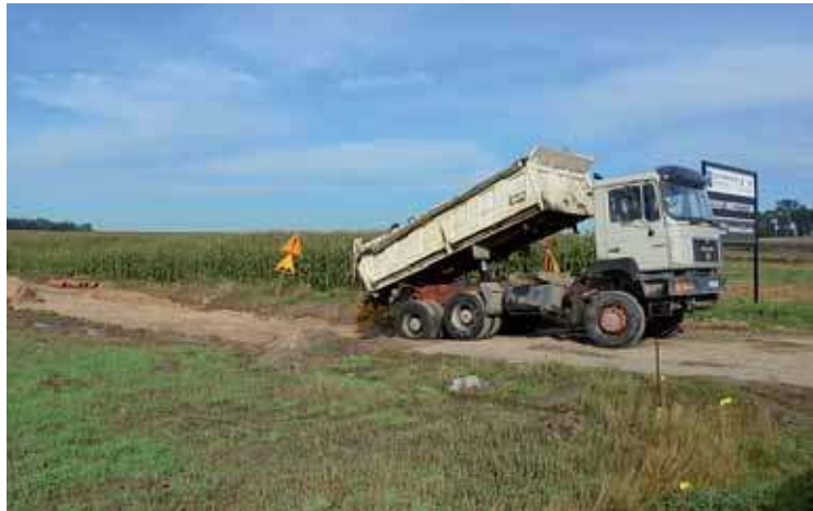
Trwa budowa nowej drogi w Żurominie
