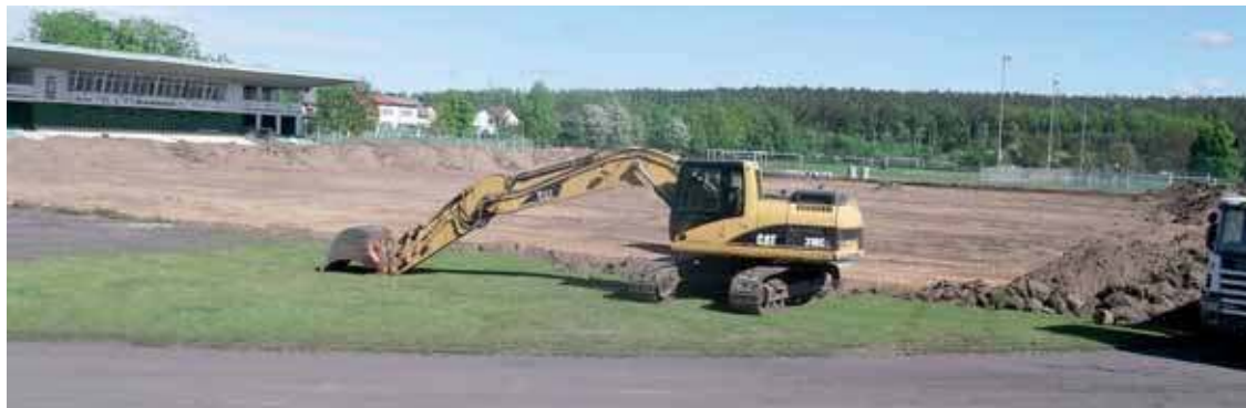
Stadion w przebudowie
