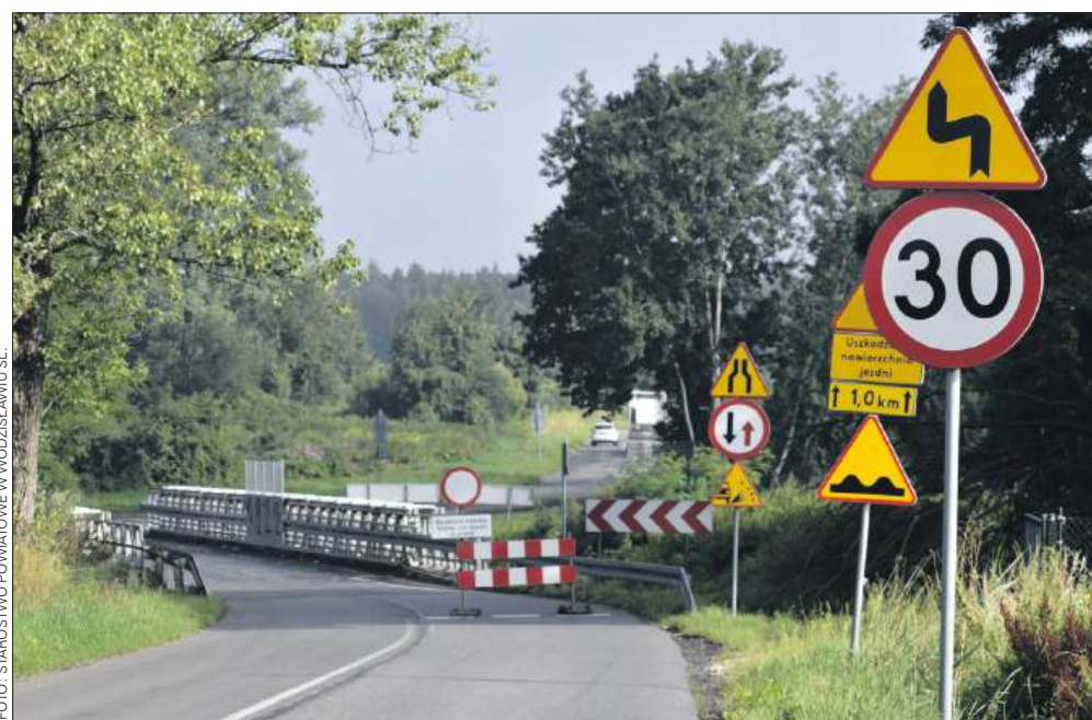
■ Utrudnienia w ruchu są spowodowane remontem drogi
