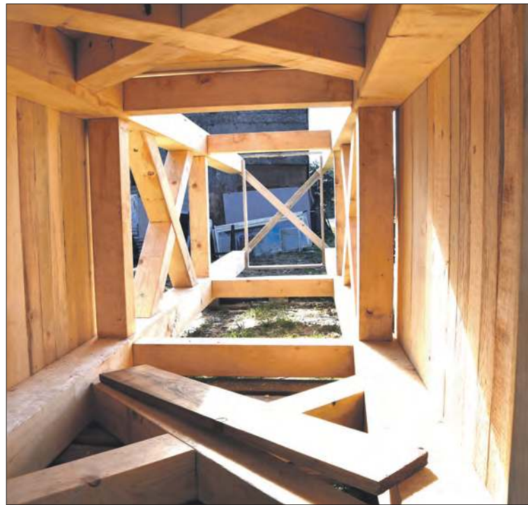
Wnętrze konstrukcji dzwonnicy
