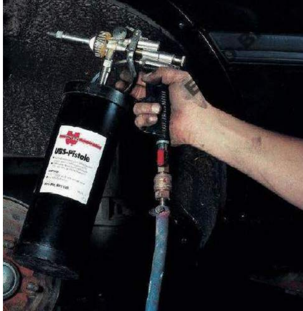
Warstwę preparatu antykorozyjnego najlepiej nanosić pistoletem pod ciśnieniem
