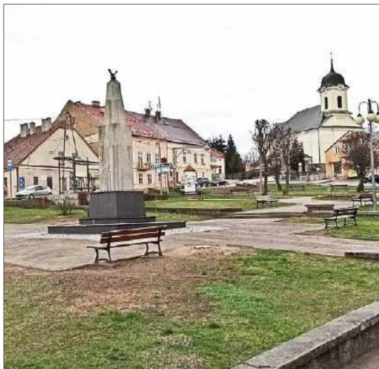
Mieszkańcy mówią, że Rynek w Brzostku zaczyna przypominać betonową pustynię. Burmistrz zapewnia, że posadzi drzewa, ale te będą rosły latami.
