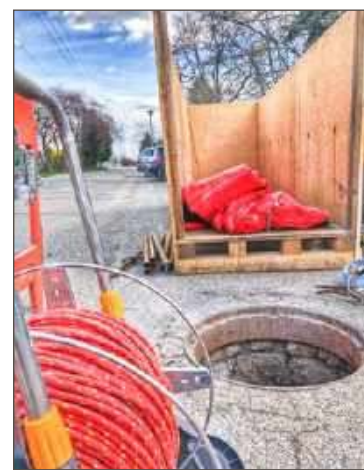
Prace przy ul. Brzegowej. fot. Wodociągi Dębickie
