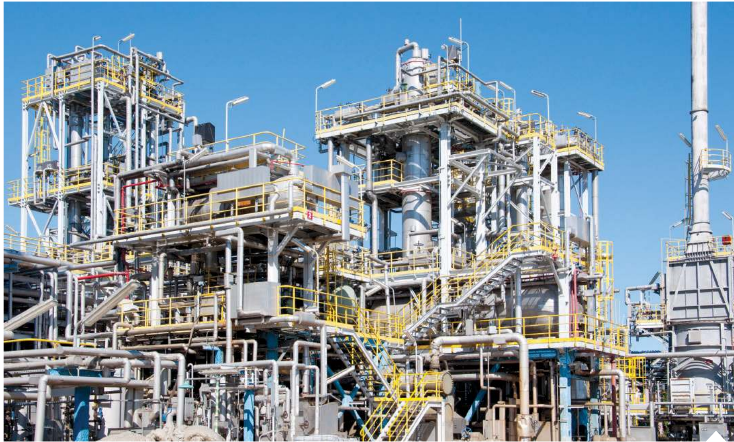
Zabudowa instalacji do odzysku ciepła odpadowego spalin na instalacji DRW VI | fot. mat. pras.
