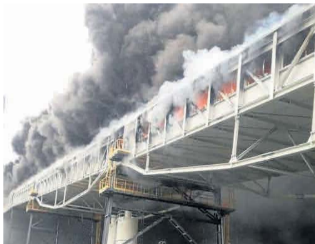
Pożar strawił około 240 metrów taśmociągu transportującego węgiel do czternastego bloku
