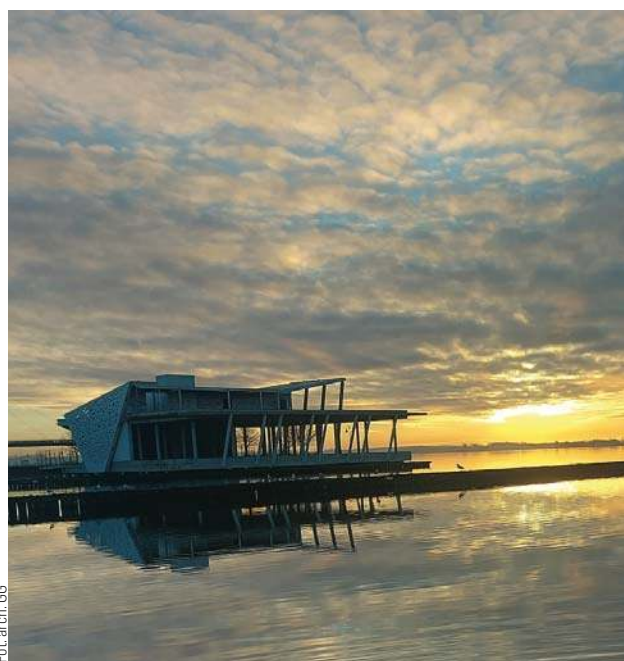
Niedokończona budowa restauracji na miejskiej plaży
