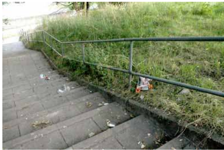
Zarówno zarośnięty teren, jak i schody są bardzo zaśmiecone
