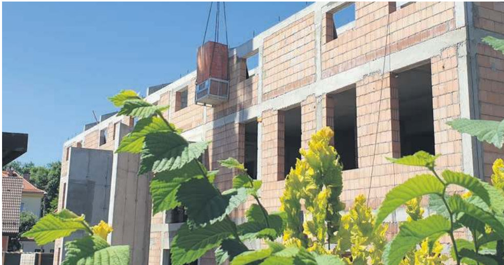
Budynek ma już dwa piętra
