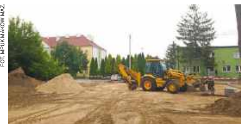
Prace zakończą się przed rozpoczęciem roku szkolnego
