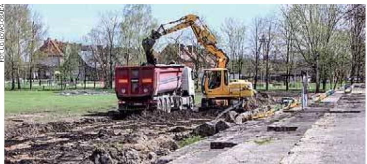
Aktualnie trwa rozbiórka obiektu
