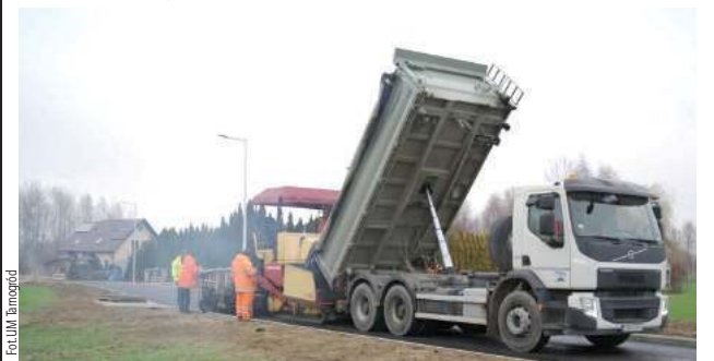
Kończą się prace budowlane w tej części Tarnogrodu
