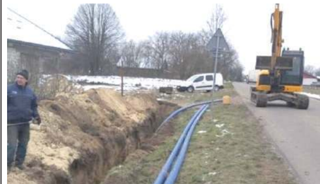
W Pulczynowie rośnie nowy wodociąg
