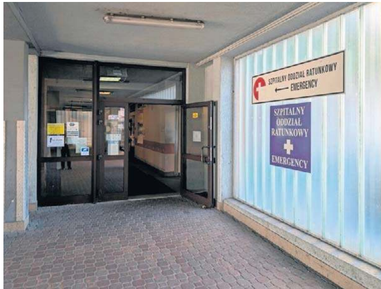
To wejście na SOR będzie zamknięte
