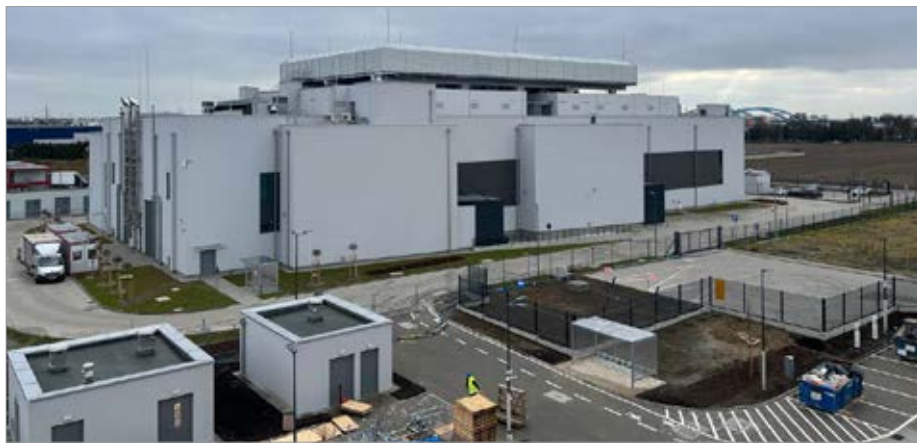
Fot. 1. Budynek centrum danych stanowiący część kampusu typu hyperscale fot. Mariusz Kordeczka
