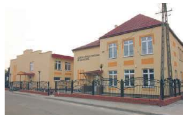
Szkoła w Ostrowie po termomodernizacji.
