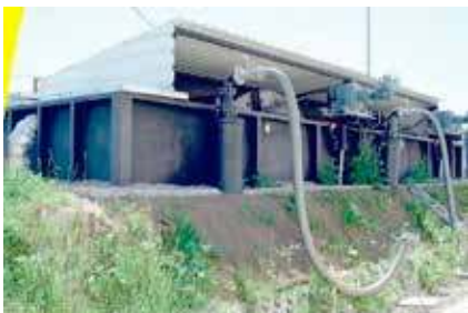
Podobnego typu oczyszczalnia stanie w Radzanku
