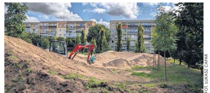
Budowa pumtracka na Osiedlu Niepodległości
