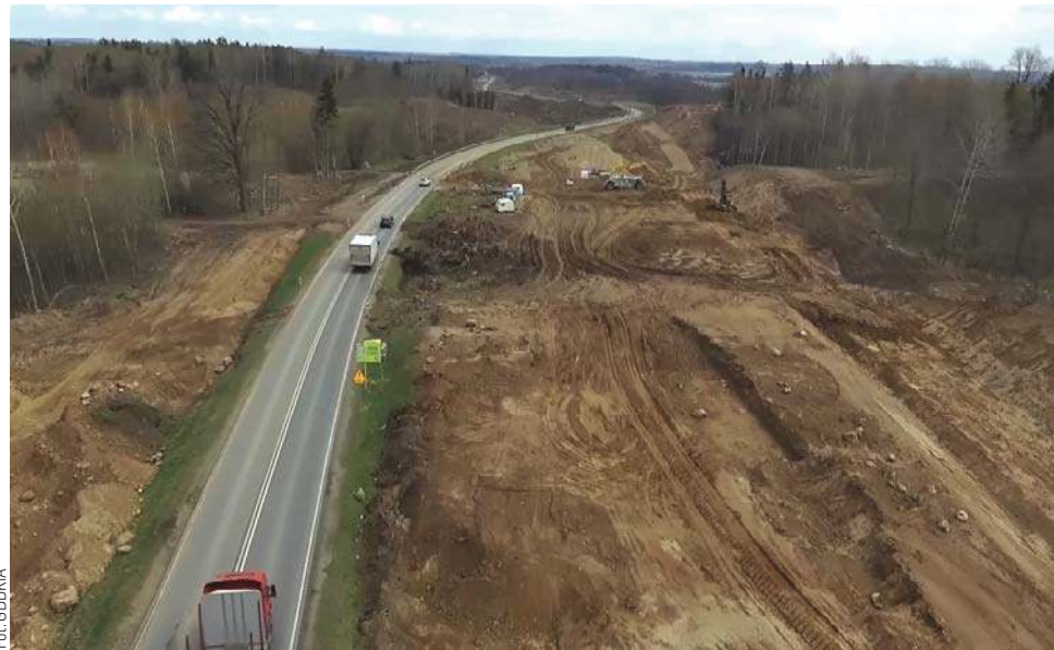
Odcinek S16 Borki Wlk. – Mrągowo ma być gotowy pod koniec 2023 roku
