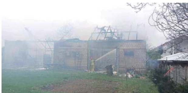
Pałił się budynek ze środkami ochrony roślin. Znana jest prawdopodobna przyczyna pożaru
