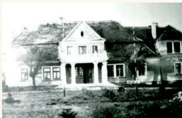
W budynku po dawnym dworze Szulc-Holnickich obecnie znajduje się Urząd Gminy
