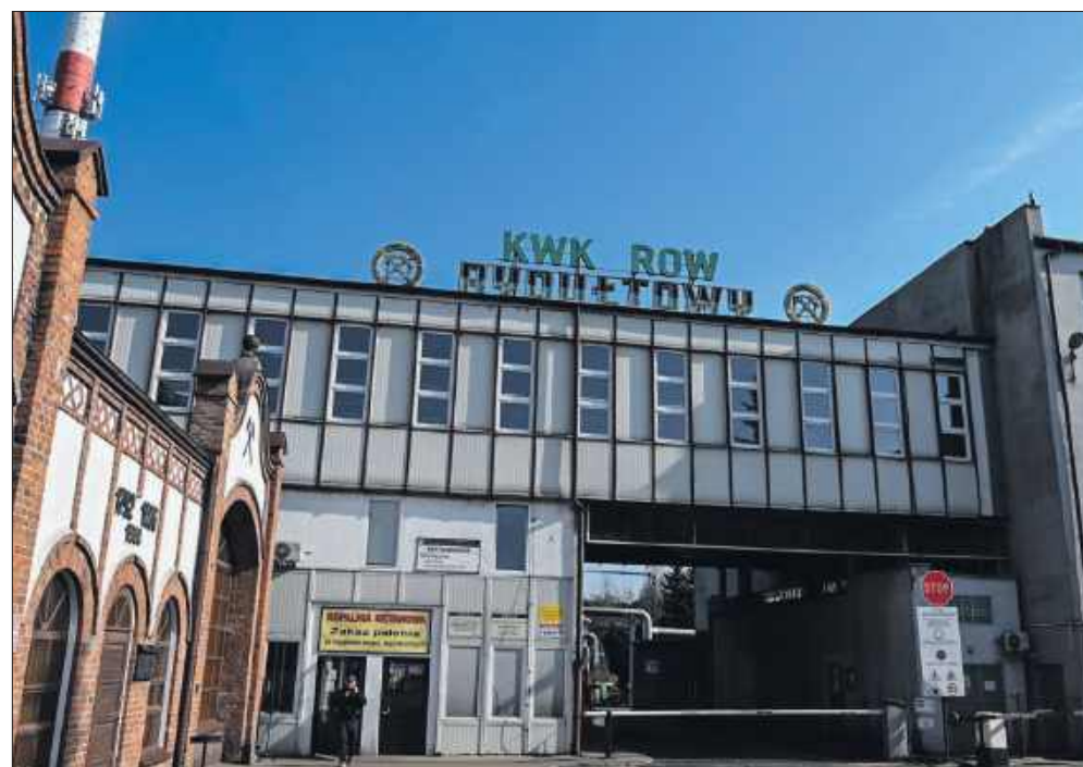
■ Wagonik stanie przed wejściem do kopalni
