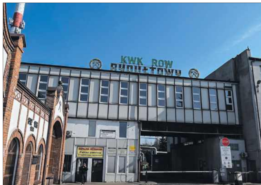
■ Wagonik stanie przed wejściem do kopalni
