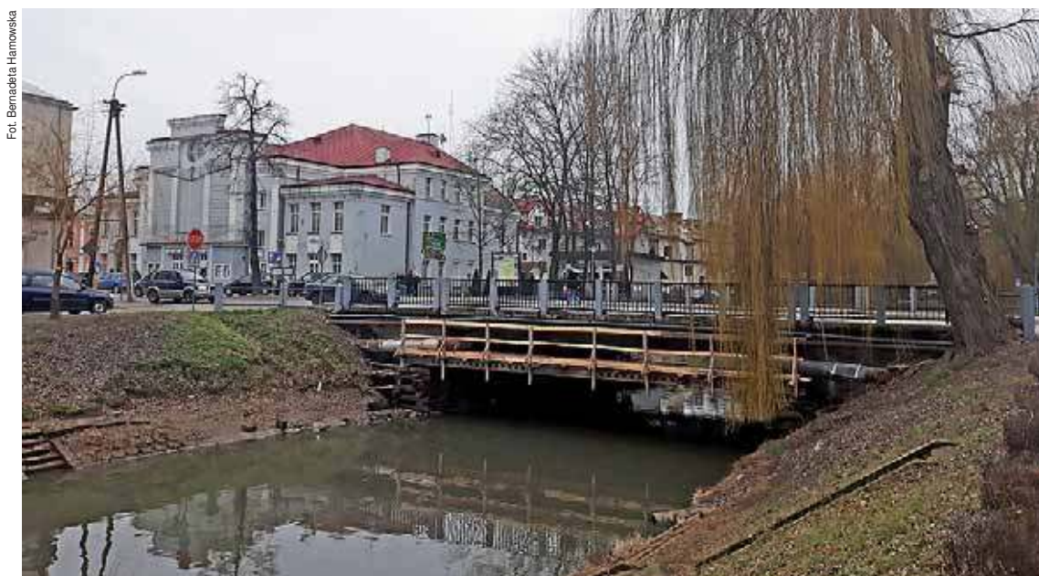
Most, zwany dawniej Kozackim, łączy plac Teatralny z widocznym budynkiem MCKiS (po lewej stronie) z ul. Świętojańską i dalej rynkiem
