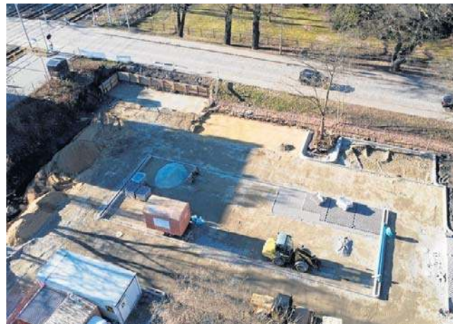
Na budowie trwa m.in. korytowanie pod chodniki, drogi manewrowe i miejsca postojowe
