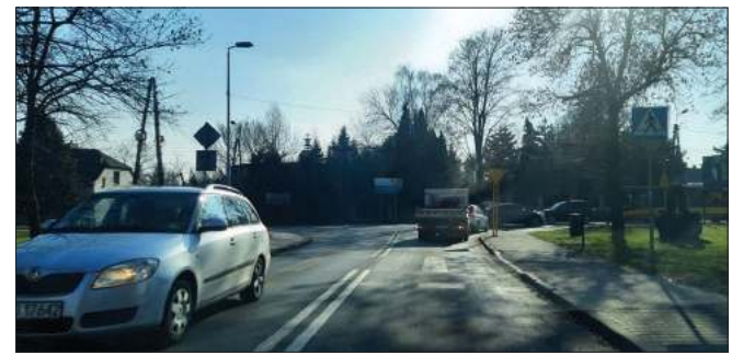
Skrzyżowanie Pszowska-Górnica w Wodzisławiu Śl. O jego przebudowie, na którą liczy wielu użytkowników tego problematycznego miejsca, mówi się od dobrych kilku lat.
