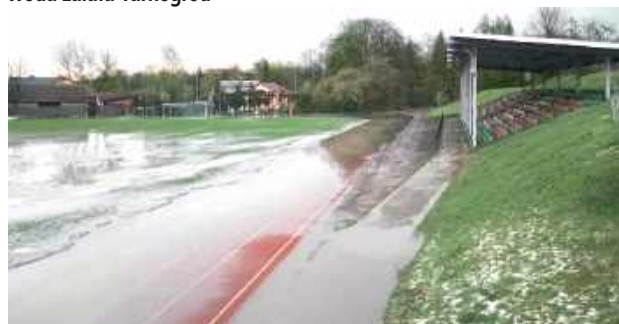
Stadion w Tarnogrodzie kompletnie zniszczony przez wodę
