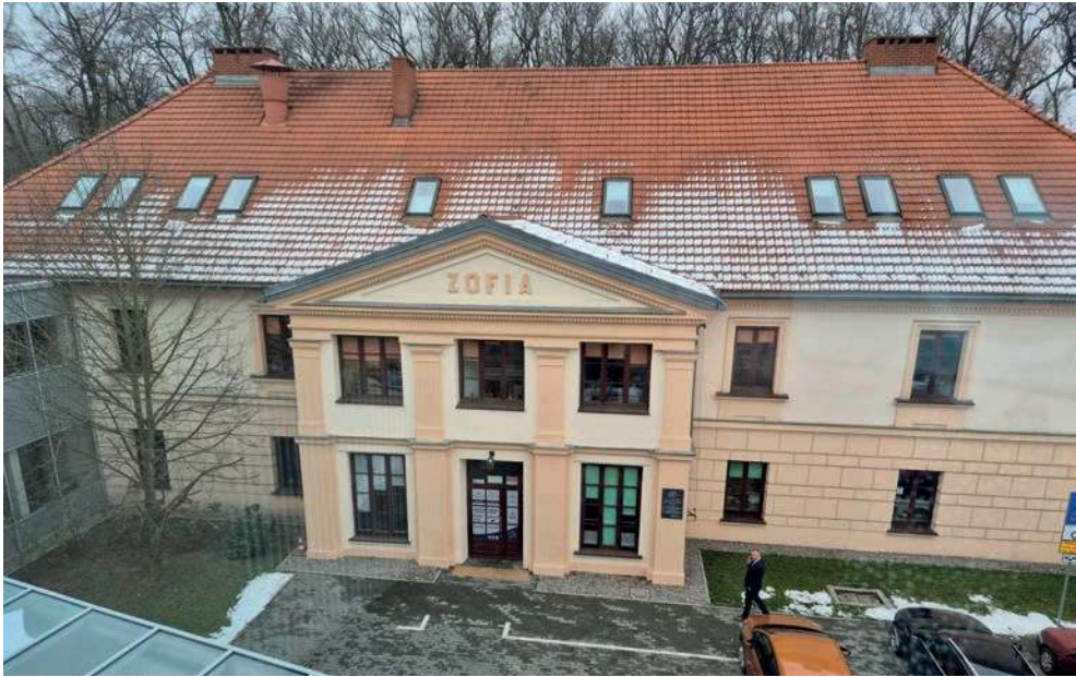
Budynek Zofia wkrótce przejdzie modernizację
