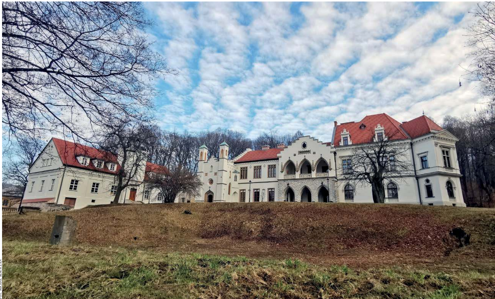
Pałac i oficyna zegarowa z odnowioną elewacją
