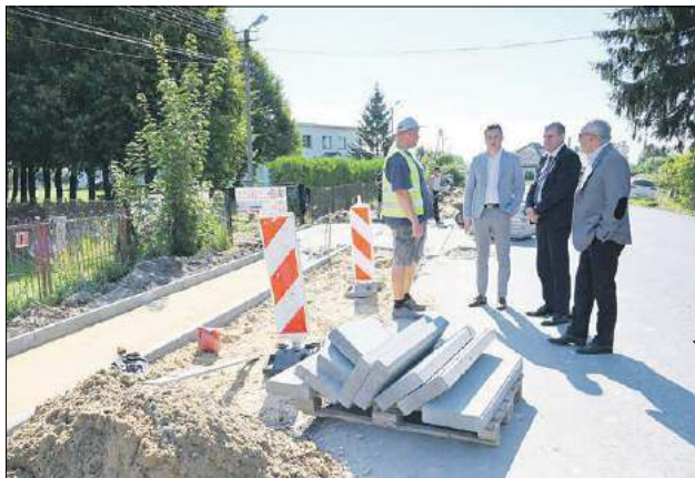
Prace na remontowanym odcinku trwają od połowy kwietnia. Po czterech miesiącach stan zaawansowania robót na miejscu oceniali Starosta Szczepan Niebrzegowski i wicestarosta Michał Zajac
