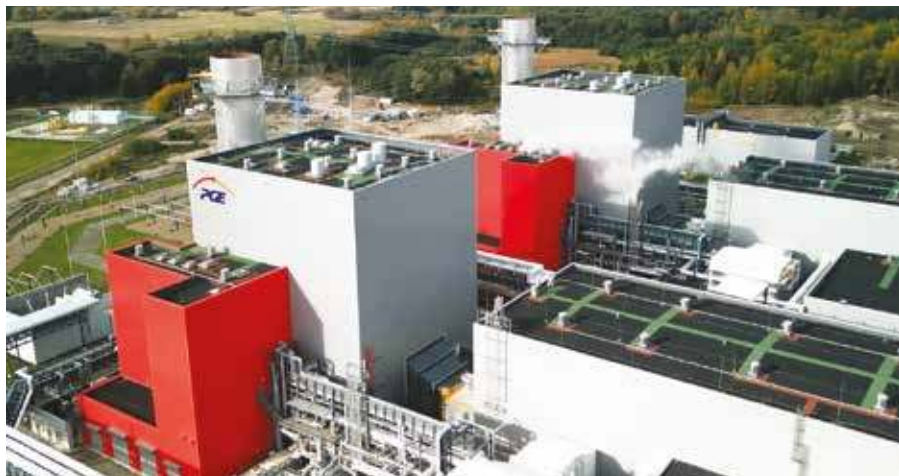
Elektrownia gazowa PGE Gryfino Dolna Odra
