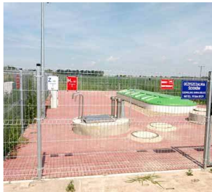
W Szemielinie wybudowano kanalizację sanitarną i oczyszczalnię ścieków oraz przebudowano sieć wodociągową
