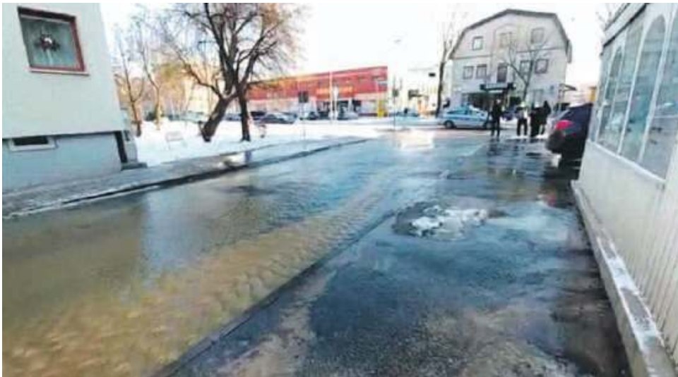
W niedzielę woda płynęła całą szerokością osiedlowej uliczki od skrzyżowania z Chrobrego
