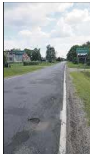
W tym roku zostanie wykonany remont odcinka drogi na trasie Dobratycze – Kostomłoty o długości 9,896km
