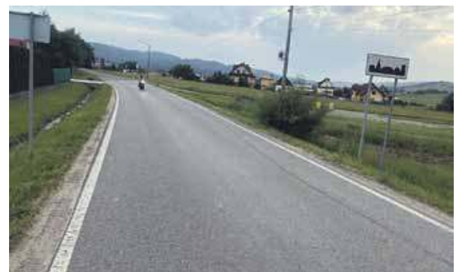
Na tym odcinku drogi powiatowej po prostu nie ma miejsca dla pieszych.
