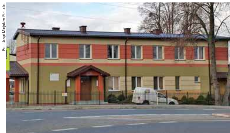
Dach świetlicy został naprawiony
