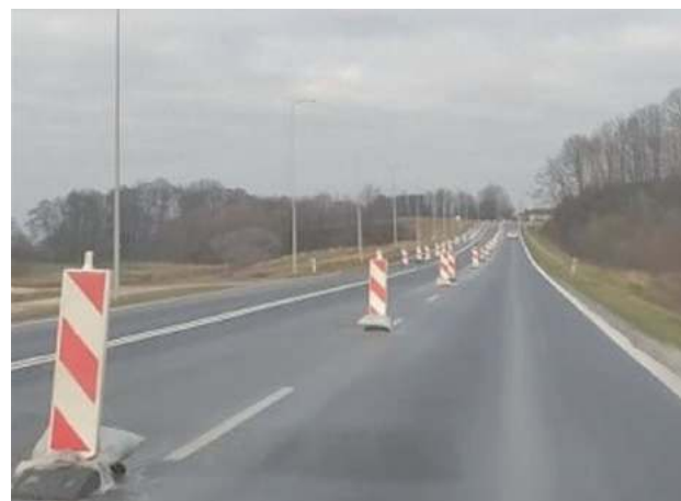
W miejscowości Zastawie zacznie się przebudowa DW nr 835
