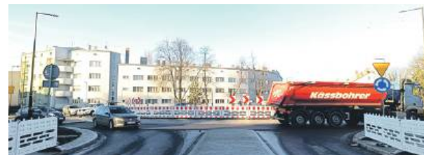
Wszystkie zjazdy i wjazdy na strzeleńskie rondo są już otwarte, ale na zakończenie prac trzeba jeszcze poczekać
