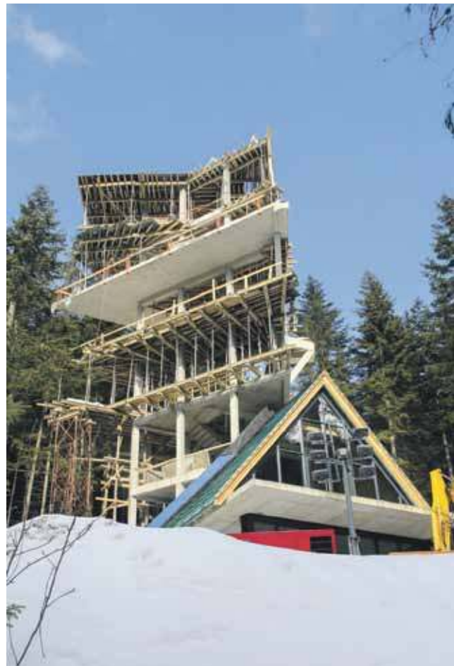
Budowa obiektów Bramy w Gorce jest już znacznie zaawansowana.
