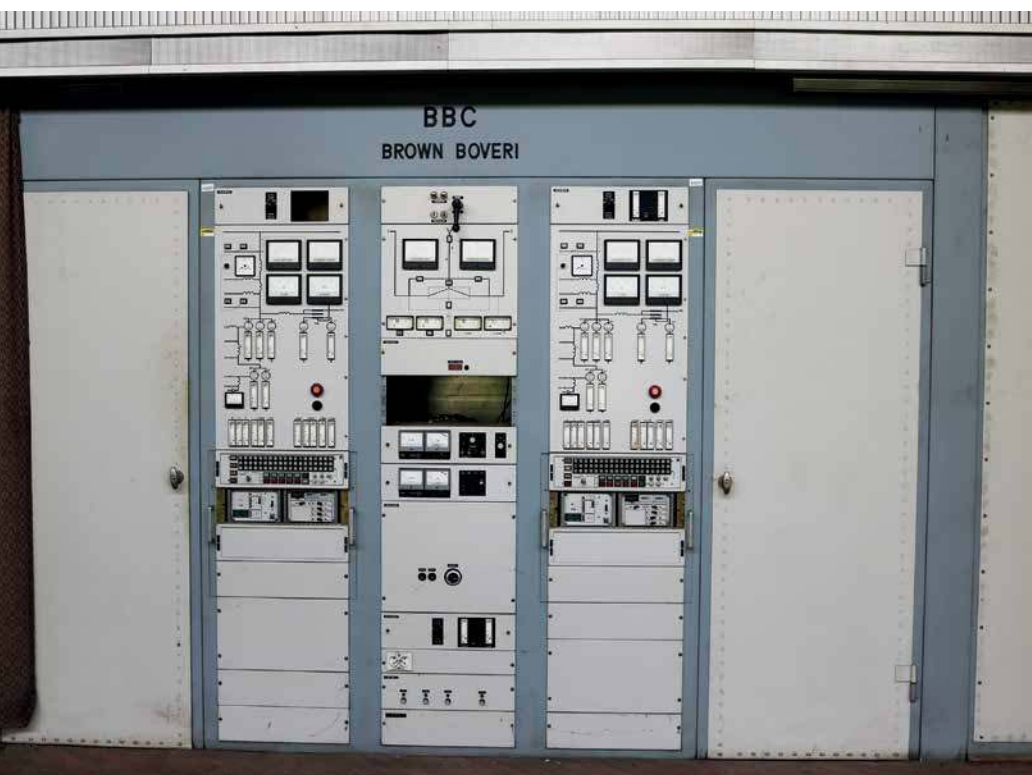
Nadajnik długofalowy Brown-Boveri & Cie SL-61 B3, pozyskany przez stowarzyszenie PK TRCN, o pierwotnej mocy 2 MW – jeden z trzech najsilniejszych nadajników na świecie (źródło: archiwum własne autora)
