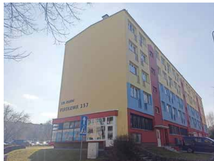
Z gminnego opisu wynika, że gdzieś w tym miejscu, zapewne pod budynkiem, znajduje się schron dla ludności
