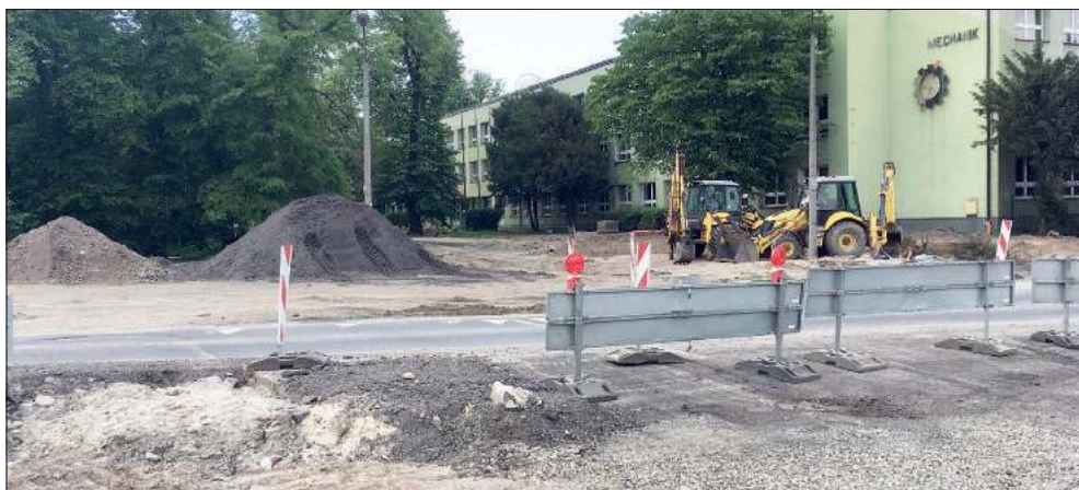
W godzinach popołudniowych robotników nie ma na placu budowy ronda turbinowego
