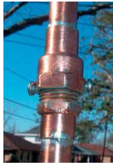
Złącze pozwalające na ustawienie anteny we właściwym kierunku i umocowanie śrubami
