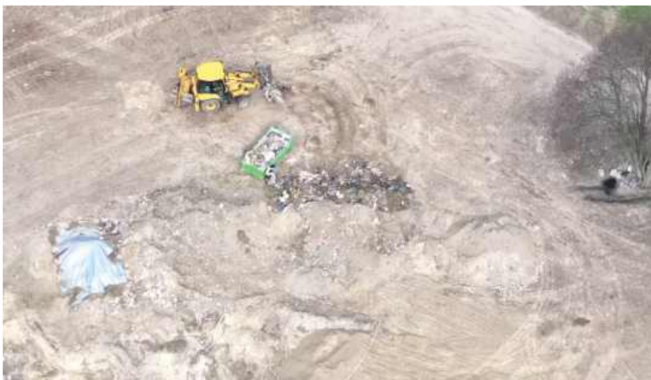
Jedna z trzech koparek pracowała w miejscu, gdzie wykopanych odpadów było bardzo dużo.
