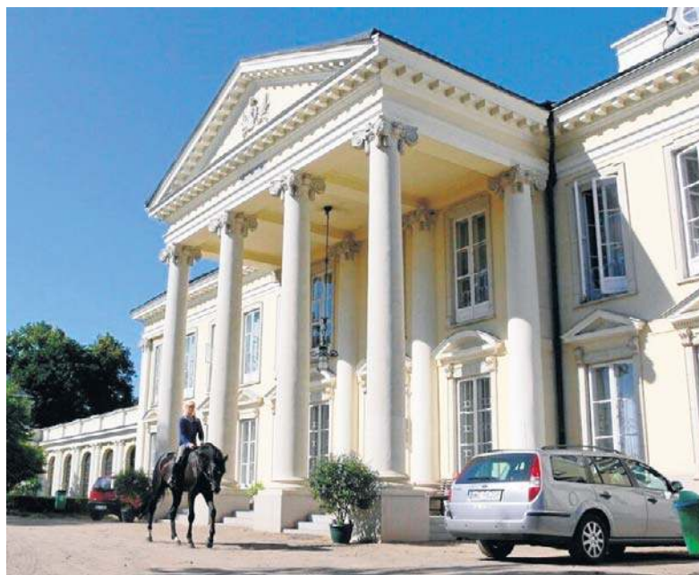
Walewicki pałac składa się z korpusu głównego i dwóch kwadratowych pawilonów po bokach, połączonych arkadowymi galeriami
