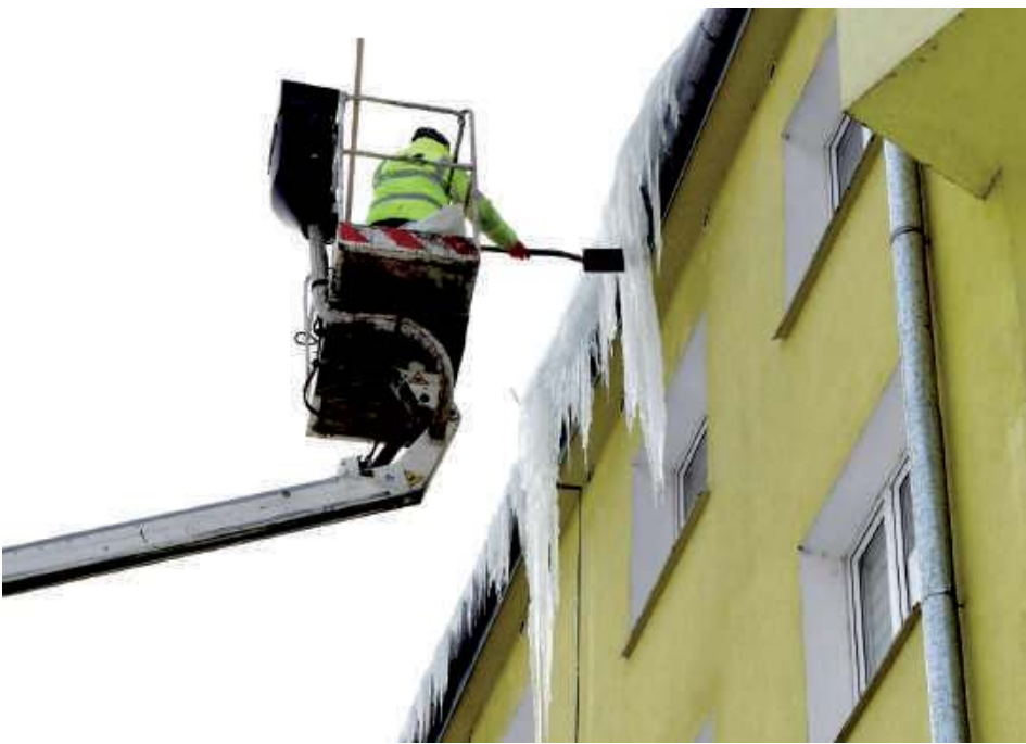
Środa, 21 grudnia. Robotnicy usuwają sope z dachu bloku przy ul. Obrońców Pokoju w Łęcznej za pomocą łopaty i długich drewnianych tyczek
