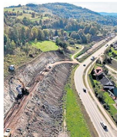
Widać już zarys nowego peronu w Mszanie Dolnej
