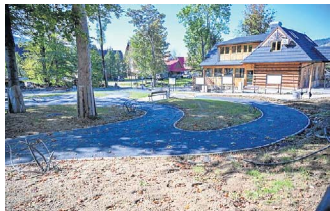
Jest nowy wykonawca miasteczka rowerowego w Zakopanem. Roboty idą pełną parą
