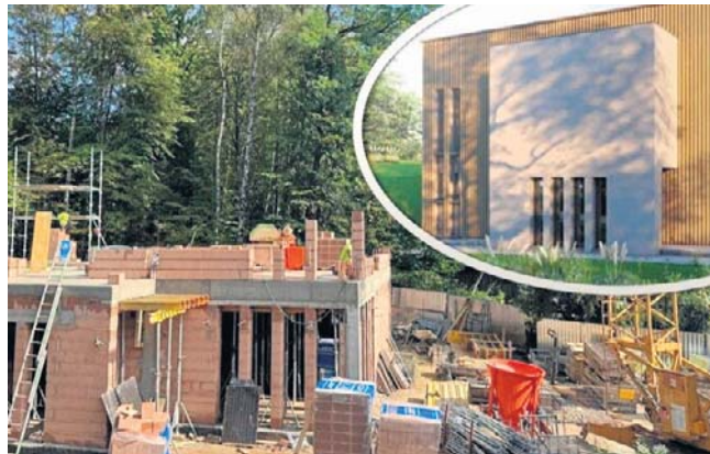
Nowoczesny budynek powstaje na terenie skansenu. Znajdzie się w nim m.in. sala wystawnienna i toalety
