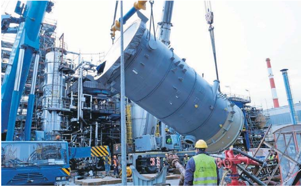
Prace w rafinerii w trakcie postoju remontowego w latach 2021-2022
