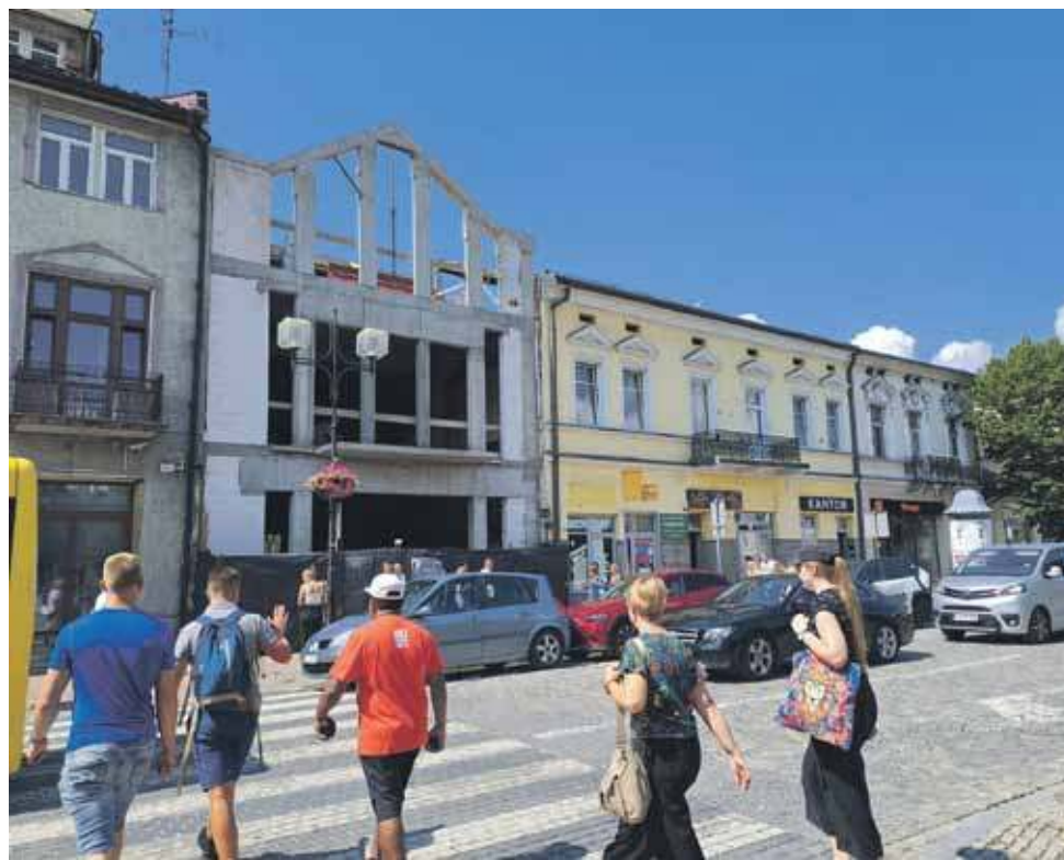
Widoczny jest już zarys frontu powstającego hotelu.
