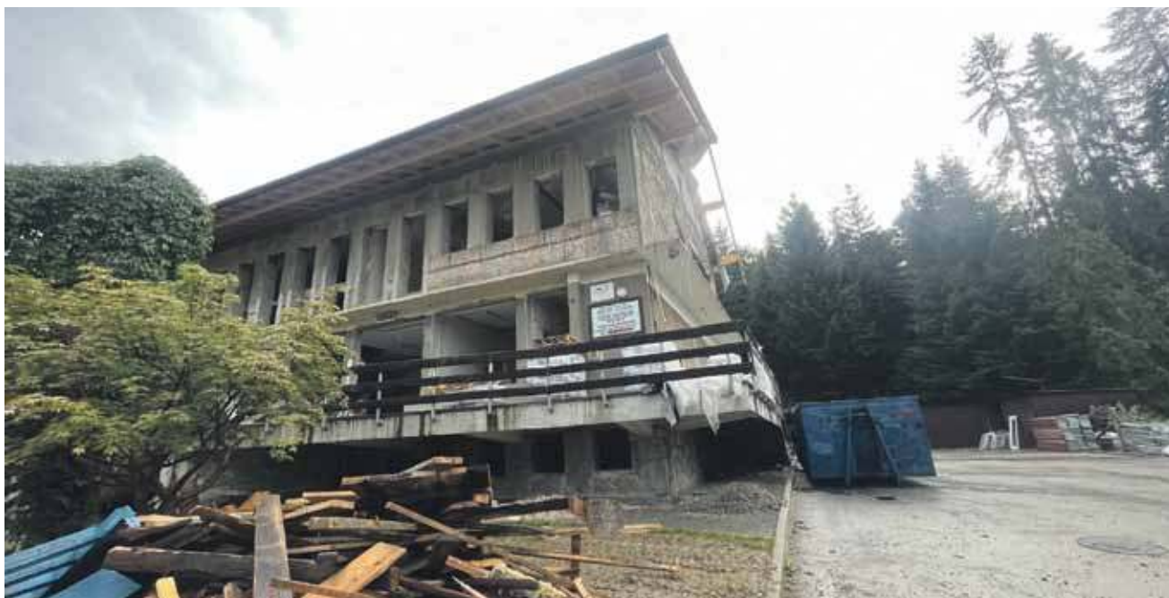
Stacja Centralna w przebudowie.
