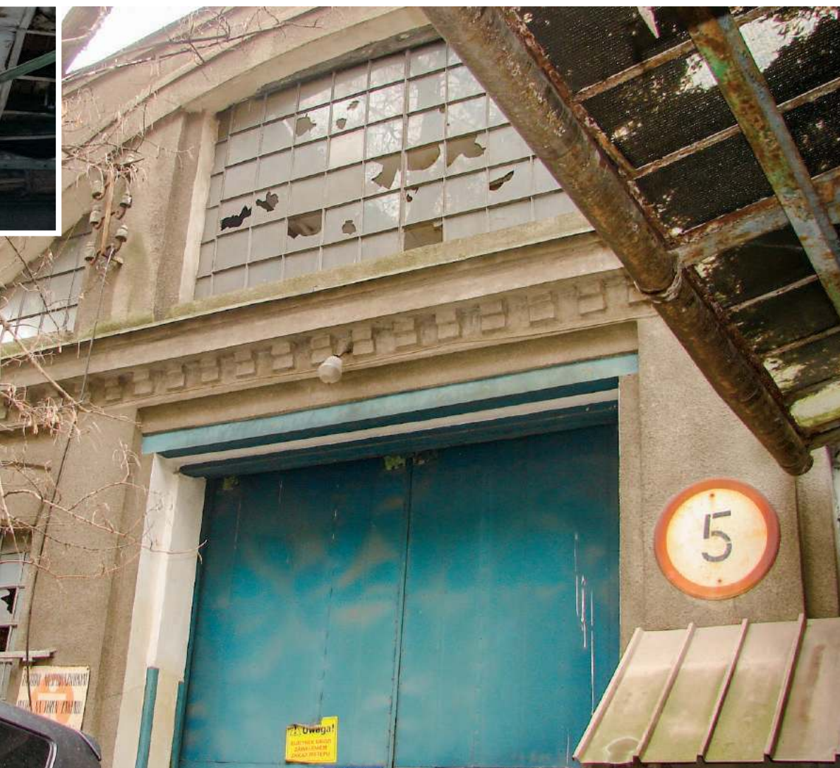
stalowej konstrukcji częściowo zawalonego dachu | fot. Janusz Sujeci/Gazeta Polska
